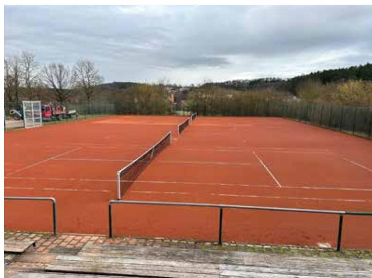
Die Lösung: Ein Gemisch aus rotem Splitt, Tennisand und elastischem Binder führt zu einer dauerhaft festen, ebenen und auch dämpfenden Oberfläche. Darauf wird Tennissand gestreut (der gleiche oder gröberer wie bei den Sandplätzen). Die optische Erscheinung und die Spieleigenschaften sind sehr nahe am Original-Sandplatz.
